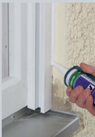
Trvanlivé a pružné zaplnění vnitřní a vnější připojovací spáry.
