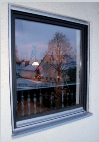
Staré nefunkční okno bez těsnění a tepelně-izolačních dvojskel!
