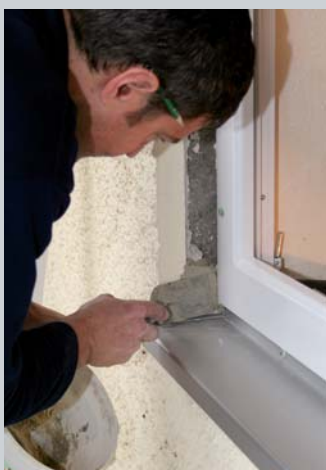
Začištění ostění okna.
