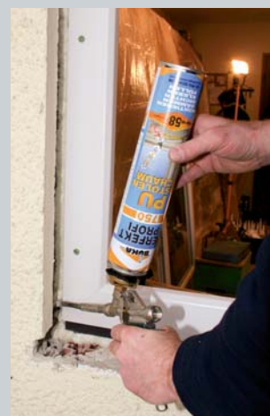
Vypěnění-zateplení PUR pěnou.
