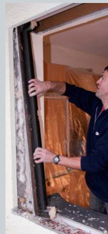
Šetrná demontáž starého dřevěného okenního rámu.
