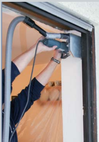
Demontáž starých dřevěných rámu pomocí speciálních nástrojů.
