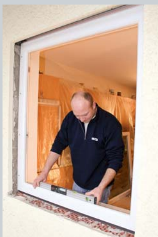
Montáž a usazení nového okenního rámu.
