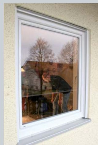
Nové okno šetřící energii.
