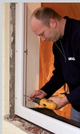
Přípevnění nového okenního rámu.
